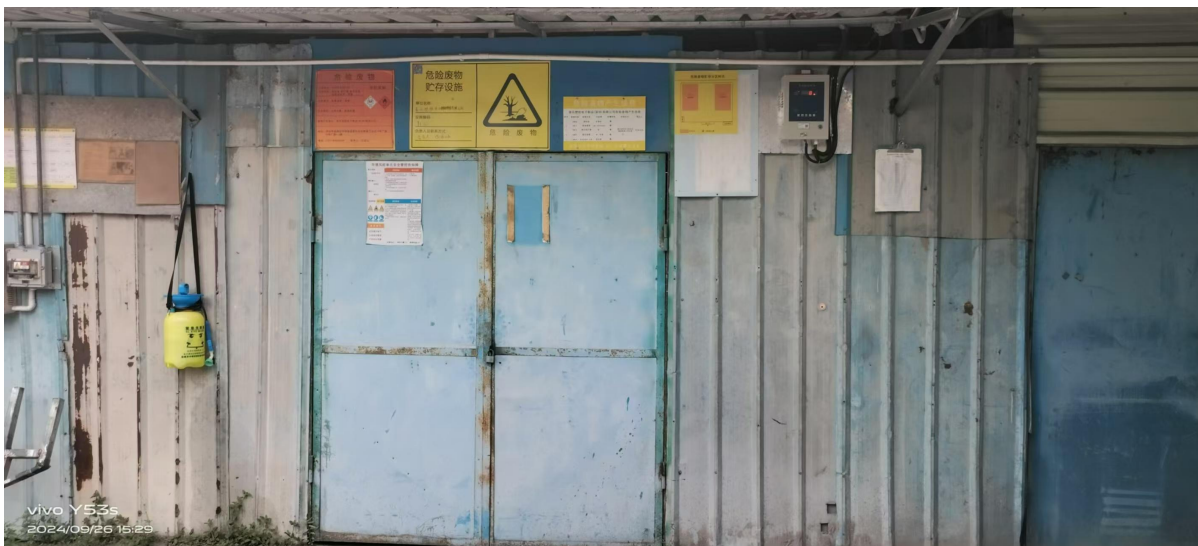
项目危险废物暂存仓
